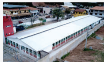
Obras de recuperação e de manutenção de prédios públicos, com 192 ações (pintura, elétrica, hidráulica, etc). Entre os locais revitalizados o Centro Administrativo Manoel Machado de Freitas e as escolas José Alves Ferreira e Profª Mariana Leite Guimarães, no interior.
