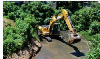
Drenagem do Rio Paquequer, feita pelo INEA (Instituto Estadual do Ambiente), a pedido da Prefeitura.
