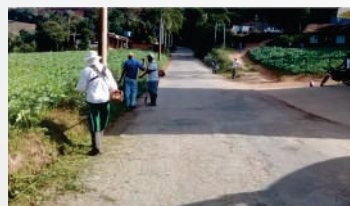
Recuperação de mais de 100 km de estradas no interior do município. Entre as ações, roçada, operação tapa-buraco e nivelamento das vias.
