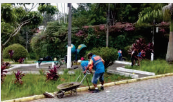
Mais de 250 ações de capina, roçada e recuperação de paralelepípedos.
